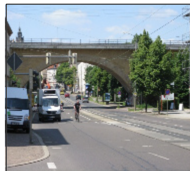
Georg-Schumann-Str. in Richtung Viadukt
