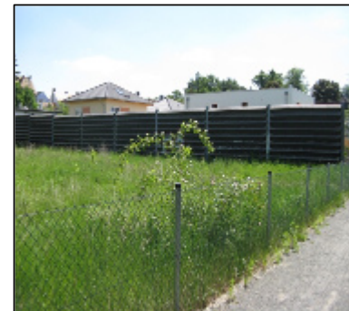
Vorhanden Lärmschutzwand am Knoten Essner-/ Delitzscher Straße
