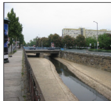
Ist-Zustand der Partheufer
